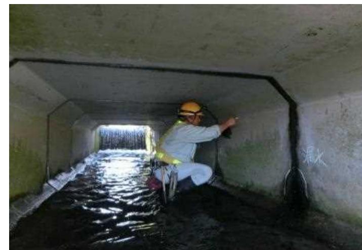
コンクリート劣化・継ぎ目等の調査
