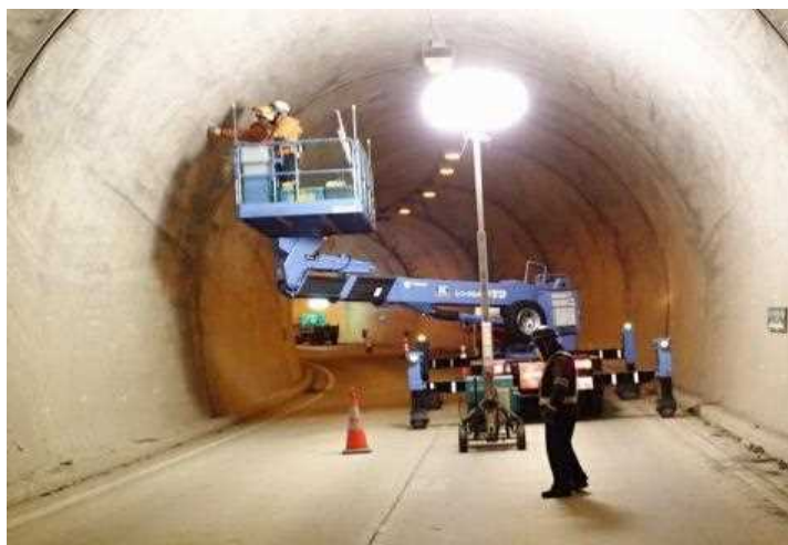
コンクリート劣化・空洞等の調査
