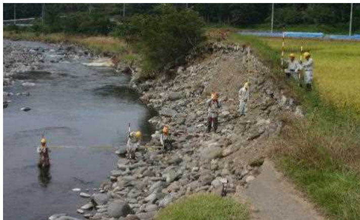
高水・濁流により石張り護岸崩壊 ポール横断測量により被災規模の把握
