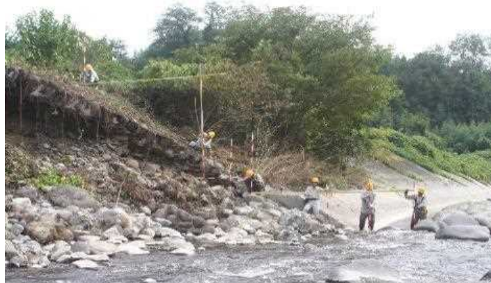
高水・濁流により石張り護岸崩壊 ポール横断測量により被災規模の把握
