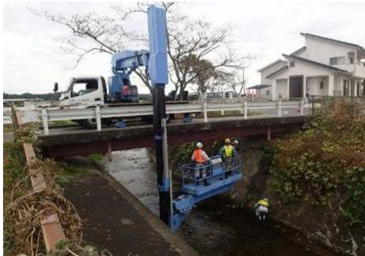
橋梁点検車による桁下点検
