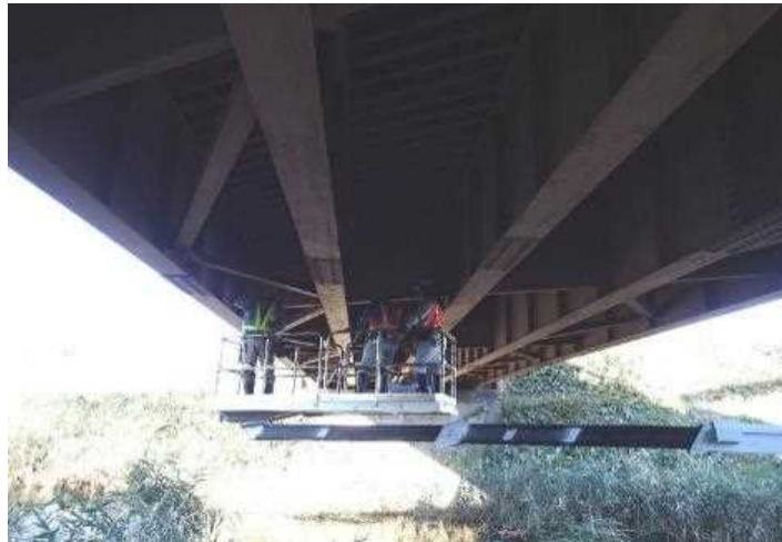
鋼橋下部(腐食・劣化・ボルト締付・破損等調査)
