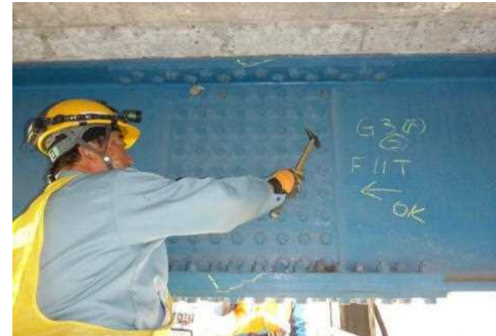
ボルト締付け状態 打音調査
